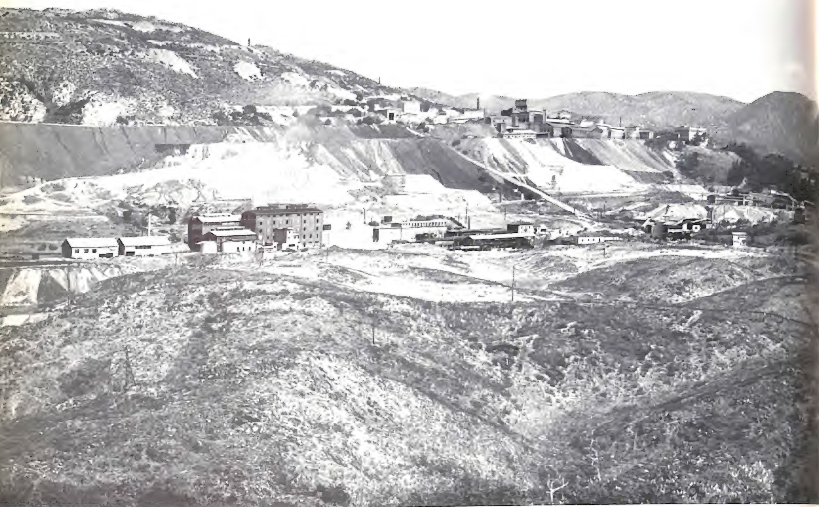
Panorama di Monteponi da Sud-Ovest. 1950.
